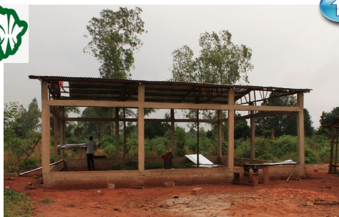
La salle de classe en construction
