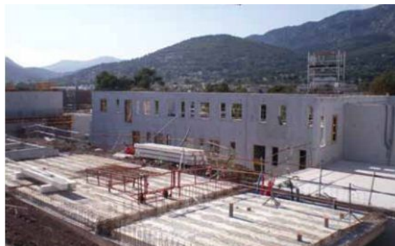
Dalle de béton des futurs bâtiment de Supméca Toulon
