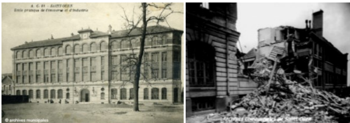
Photos du bâtiment, avant et après le bombardement
