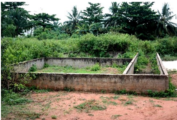
Fondations de l'école, que les étudiants vont finir de construire
